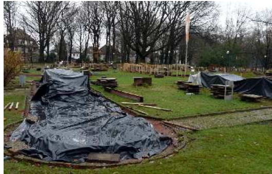
Renovierungsarbeiten an den Bahnen im Bochumer Stadtpark schreiten voran. Foto: wihe
