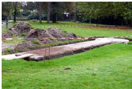
Blick auf die Bahn 1 am Overbeckshof.
