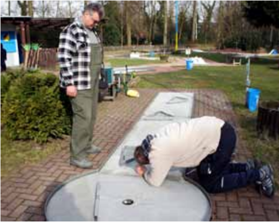
Bahn 3 wird neu aufgebaut. Foto: wihe
