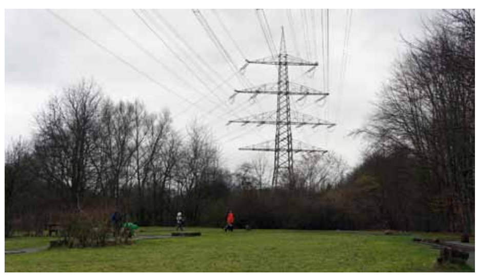
Blick auf die Anlage in Witten-Herbede.
